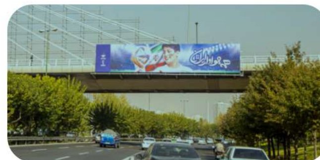
اتوبان شیخ فضل الله، پل کابلی برج میلاد، مسیر شمال به جنوب
