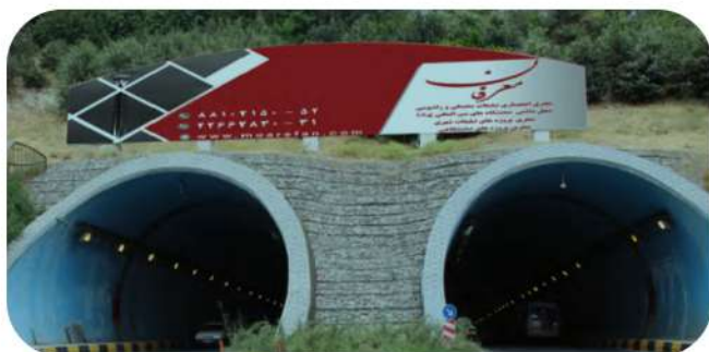
مسیر ورودی تونل، عرشه پل
